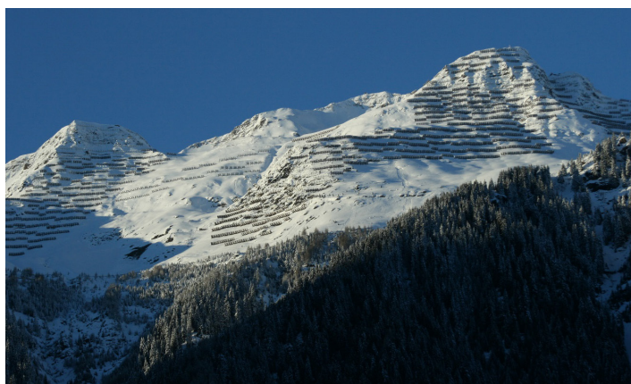
Una parte dei ripari valangari di Pontino (© Studio Gendotti, 2025)
