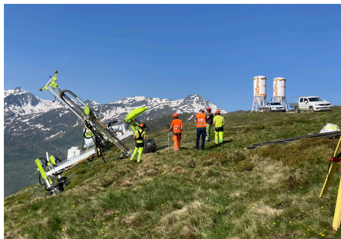
Perforatrice utilizzata per l'impianto Sedrun Solar (© Studio Gendotti, 2025)
